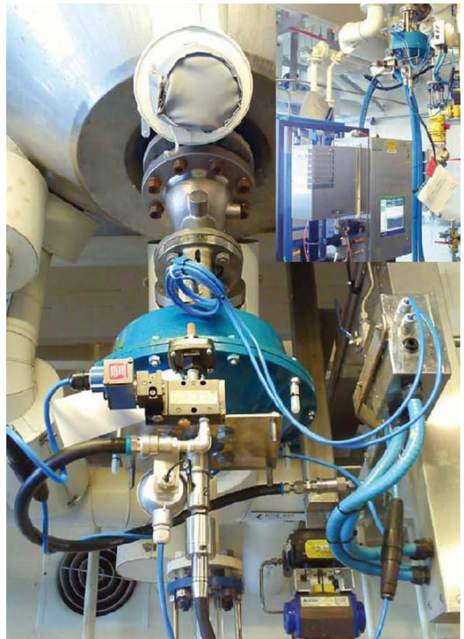
Dnový výpustný ventil SchuF s vestavěným IR čidlem, osazený na reaktoru, a připojený k monitorovacímu zařízení
